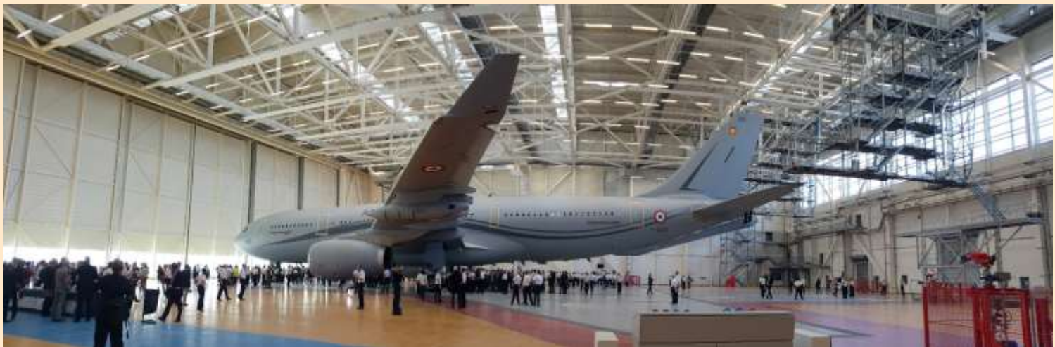
Dans le nouveau hangar de maintenance
